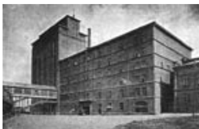
Mylly (B) ja siilorakennus (G) korotettuna 1938. Hirsirakenteiset siilot kätkeytyvät tiilijulkisivun taakse.
